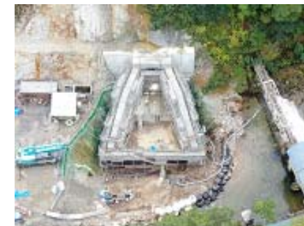
転流工（吐口構造物）
