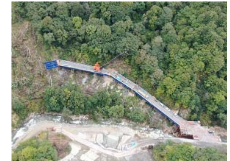
右岸工事用道路
