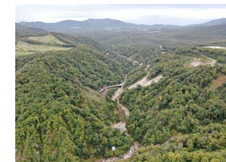
下流側より全景
