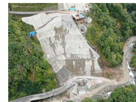
左岸重機道路
